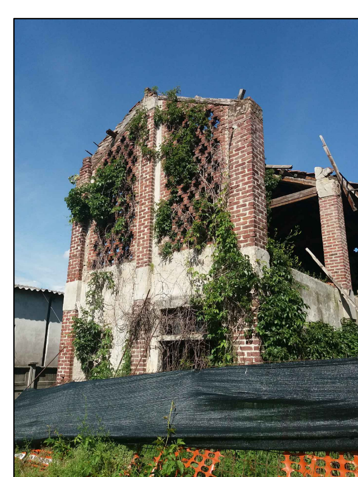
9 MURATURE E TRAMEZZI DA VERIFICARE ED EVENTUALMENTE RIMOVERE (UTILIZZO DI GESTELLOPLE ED EVENTUALE UTILIZZO DI PONTAGGIO STRUTTURALE)
