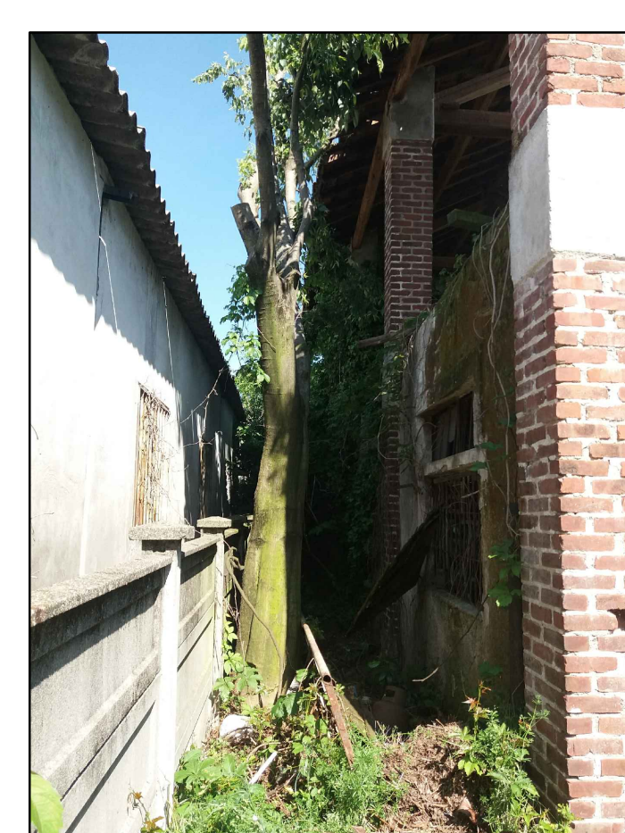
7 ALBERO DA ABBATTERE (UTILIZZO DI GESTELLOPLE ED AUTOGRU)
