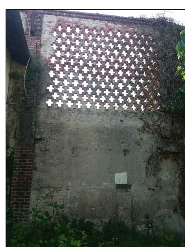
10 MURATURE E TRAMEZZI DA VERIFICARE ED EVENTUALMENTE RIMOVERE (UTILIZZO DI GESTELLOPLE ED EVENTUALE UTILIZZO DI PONTAGGIO STRUTTURALE)
