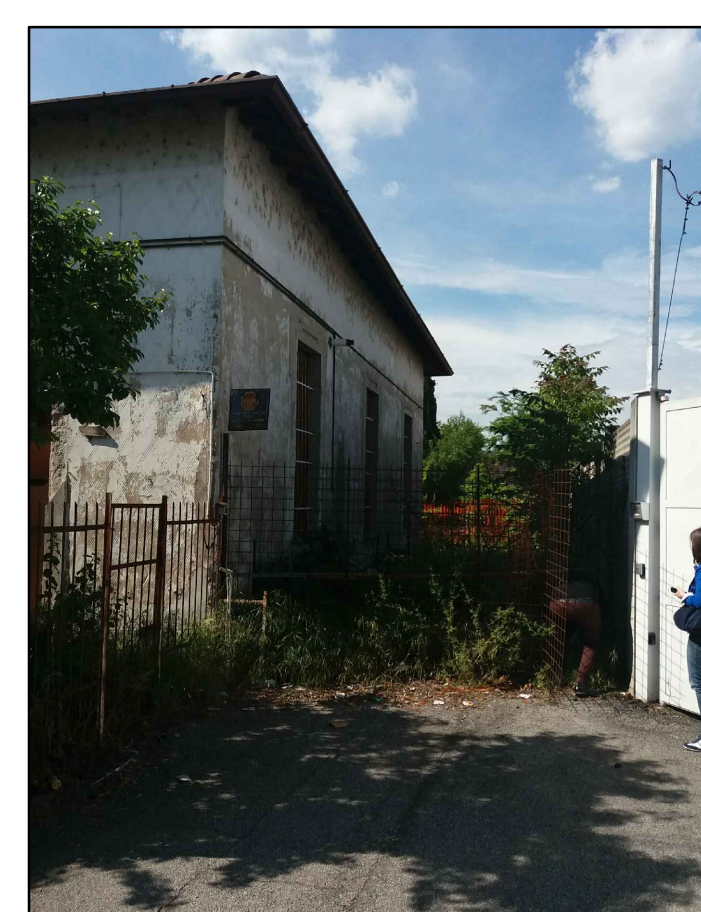
5 TERZO ACCESSO AL CANTIERE DA VIA ALFIERI (OBBLIGO DI MOVIERE)
